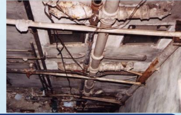
供水及排水系統破損、失修
