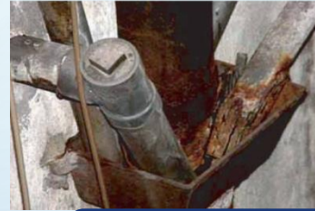
供水及排水系統破損、失修
