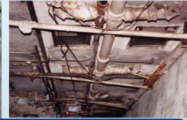
供水及排水系統破損、失修
