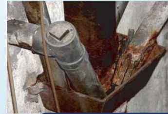
供水及排水系統破損、失修
